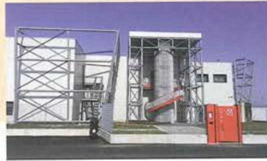
Alcune immagini del nuovo stabilimento di Casalino (No), operativo da agosto 2014.
